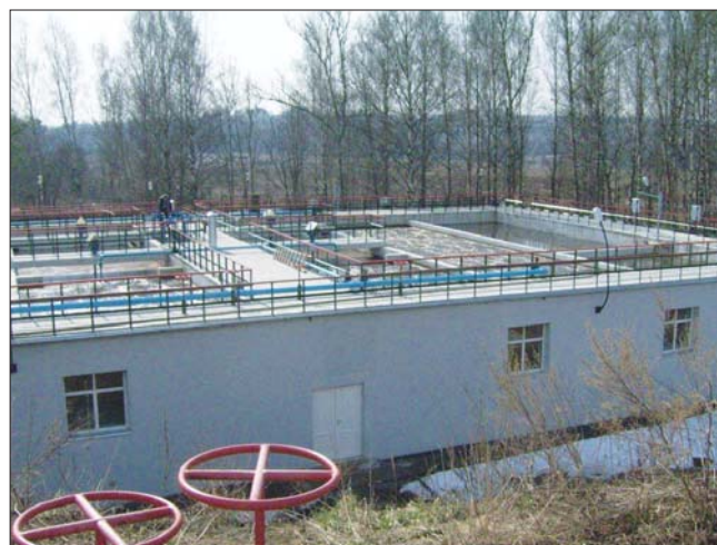
Рис. 10. Блок биологической очистки, размещенный в здании биофильтров на очистных сооружениях ФГУ «Дом отдыха «Снегири» УДП РФ
