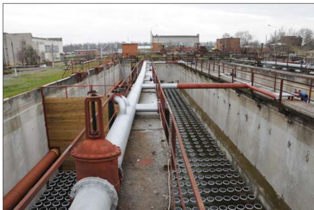
Рис. 6. Реконструкция аэротенков с использованием в зонах нитрификации мелкопузырчатых мембранных аэраторов компании SSI
