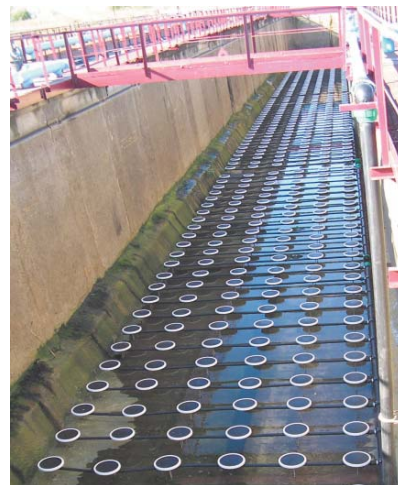
Рис. 3. Аэраторы SSI в аэротенке
