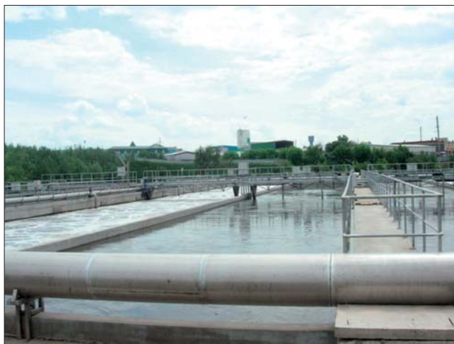
Рис. 1. Реконструированный блок аэротенков и вторичных отстойников
