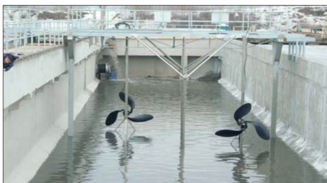
Рис. 2. Образователи потока в анаэробно-аноксидной зоне аэротенка
