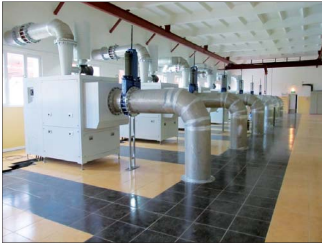
Рис. 11. Воздуходувная станция
