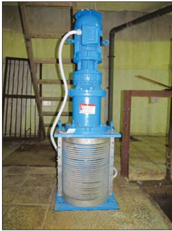
Рис. 5. Решетки-измельчители (димминуторы) фирмы Franklin Miller
