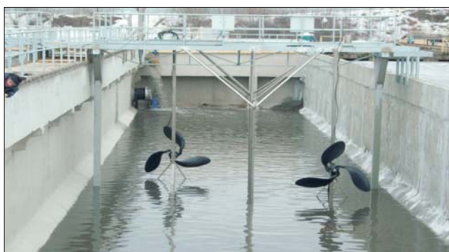
Рис. 2. Образователи потока в анаэробно-аноксидной зоне аэротенка
