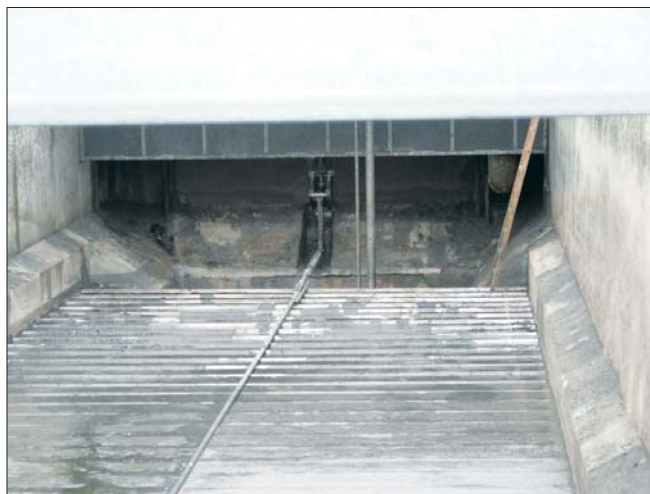
Рис. 3. Скребокное устройство
